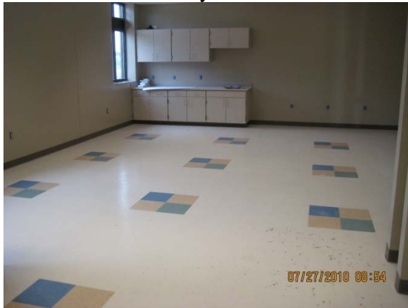
Admin. Bldg. break room
